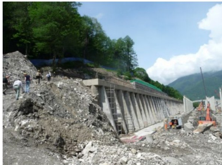
Рис. 5. Массивная подпорная стена у подножья склона, примыкающего к вокзалу
