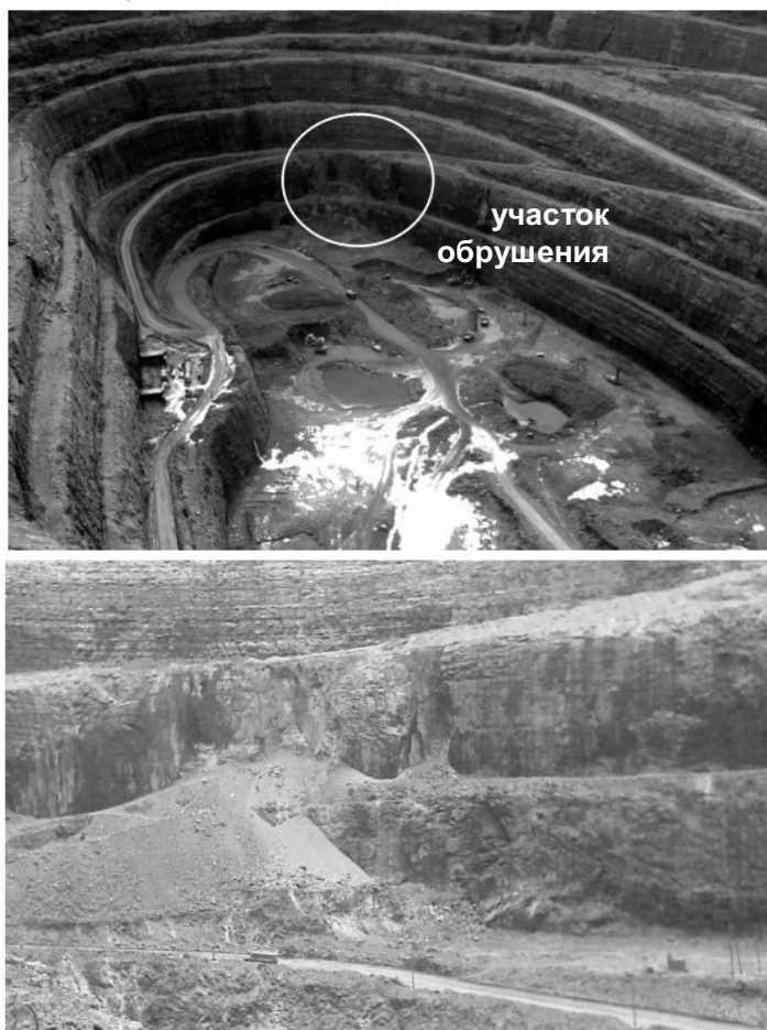
Рис.1. Участок обрушения уступа
