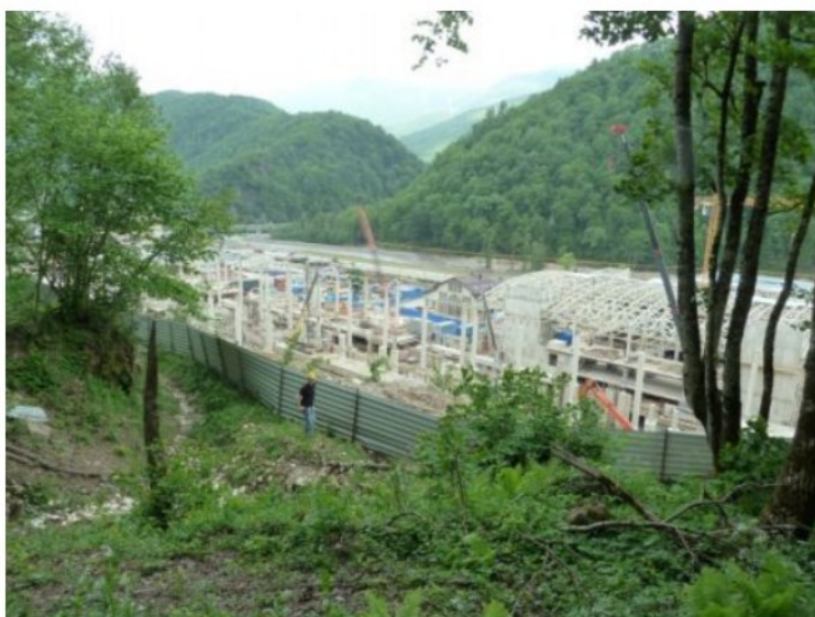
Рис. 4. Строительство вокзала Альпика-Сервис (май 2012 г.) – вид со стороны подножья прилегающего к вокзалу склона хр. Аибга
